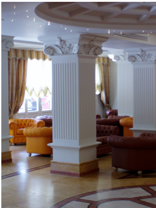
Pilastro scanalato in cartongesso, con capitello In gesso, cornici e volto a soffitto in gesso.
